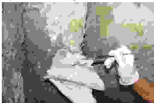
Fig. 95. Clivajul straturilor de tencuială provocat de Serpula lacrymans (original)
