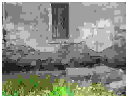
Fig. 98. Putregai brun produs în peretele unei case de Serpula lacrymans (original)
