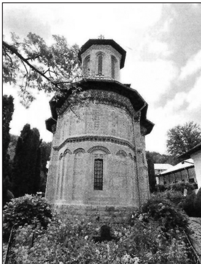
Biserica de cărămidă
