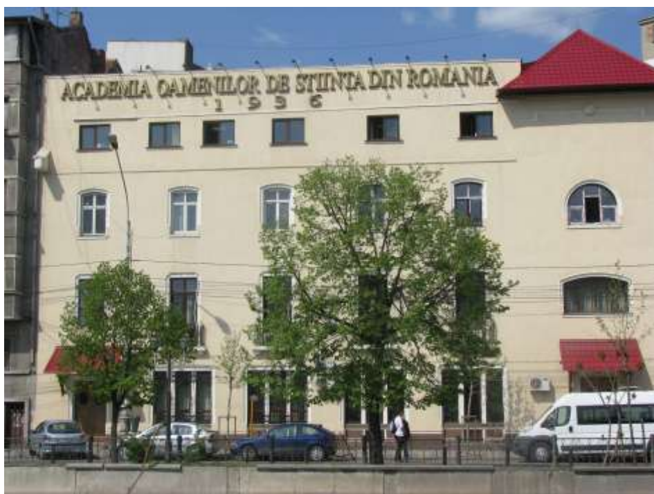
Fațada [așa cum arăta în 2003 (sus) și cum se înfățișează azi].
