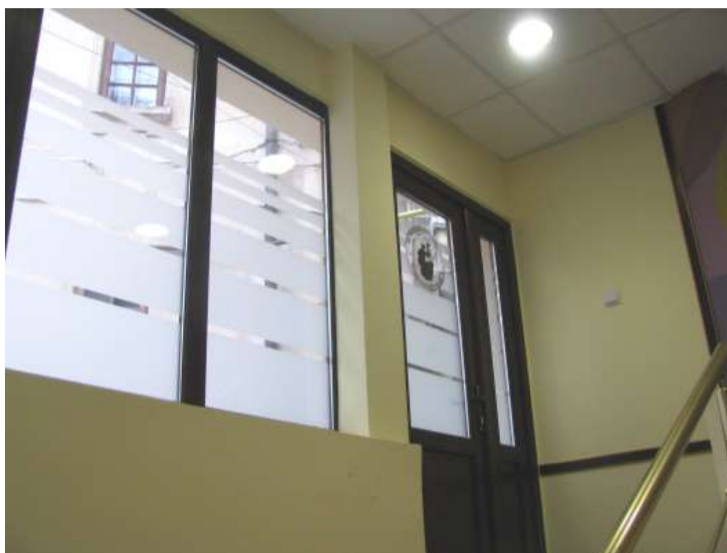
Scări de acces la sala de conferințe.
