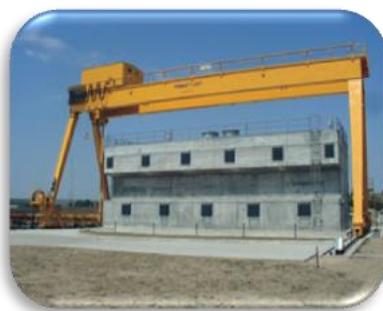
Figura 2-5. Depozitul intermediar de combustibil ars, DICA. [3]
