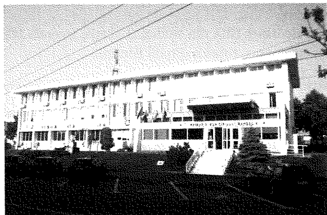
Clădirea Primăriei municipiului Mangalia
