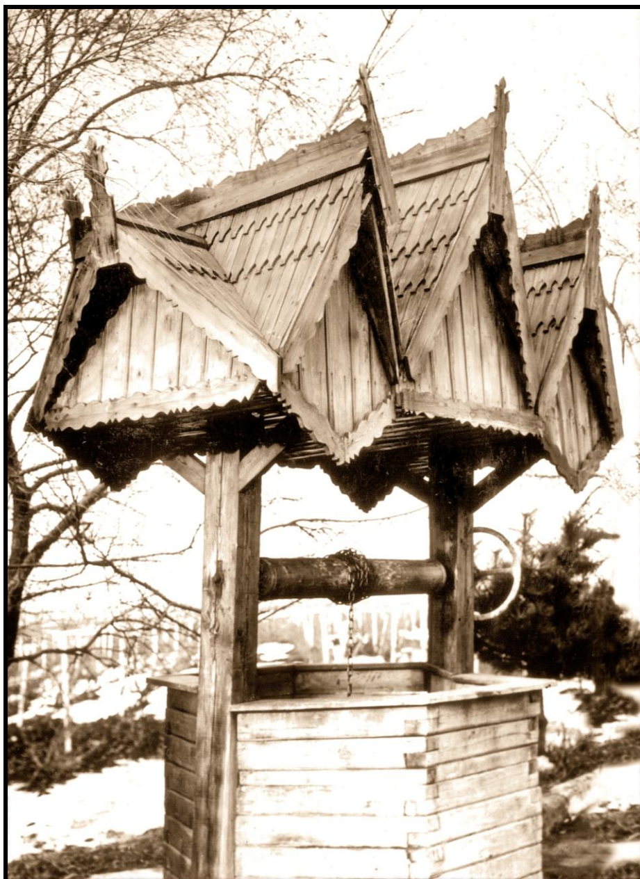
Fântână unicat din lemn, demolată, din Dealul Hînceștilor, 1976
